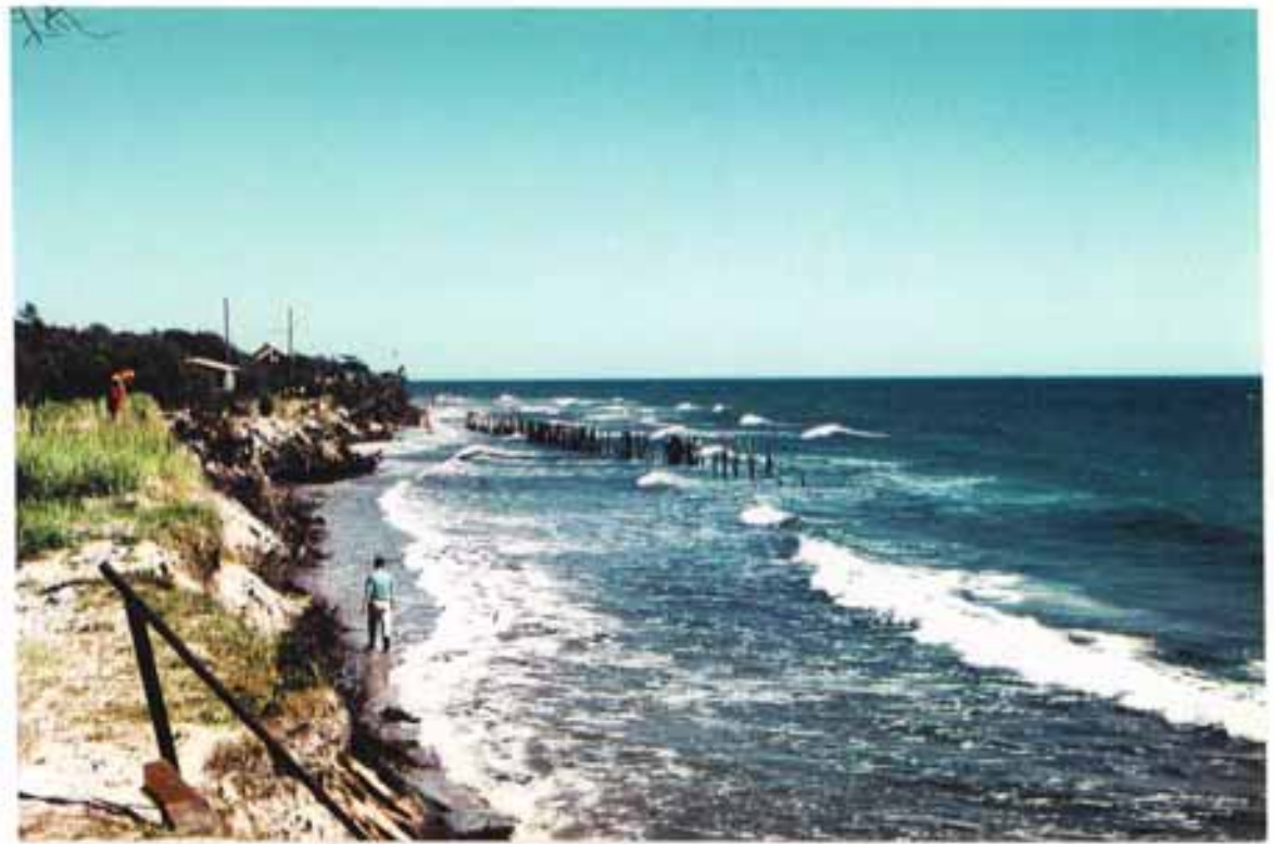
38. Erosion på väster vid Klittervägen. 1968.
