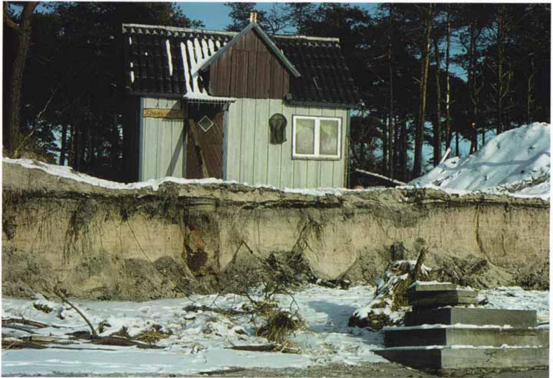
69. Havet har börjat med att ta trappan på Fiskarstugan.
