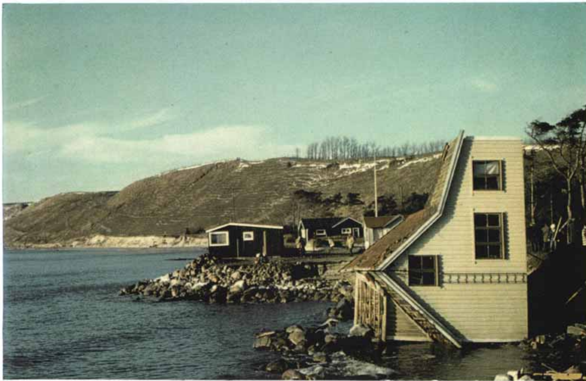
44. Salomon Krafts stuga har underminerats och fallit utåt, 1976.
