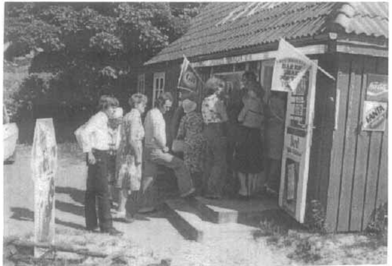
36. Kiosk på taket år 1976
